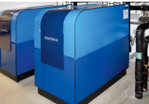
Bild 2: Zwei Adsorptionskältemaschinen mit in Summe 30 kW Nennkälteleistung
